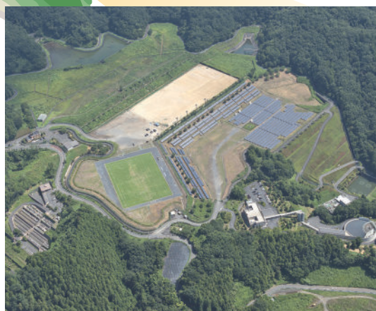
日の出町谷戸沢廃棄物広域処分場
