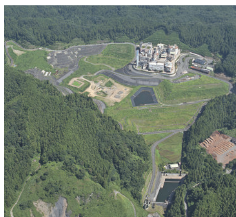
日の出町ニツ塚廃棄物広域処分場
