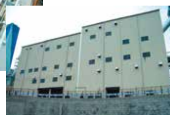
⑥ 重金属回収設備棟
