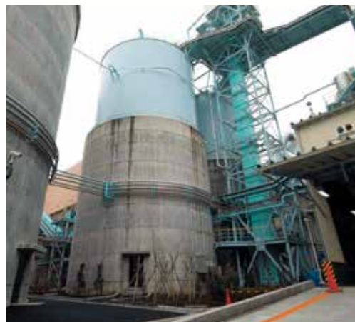
④ エコセメント貯留タンク
