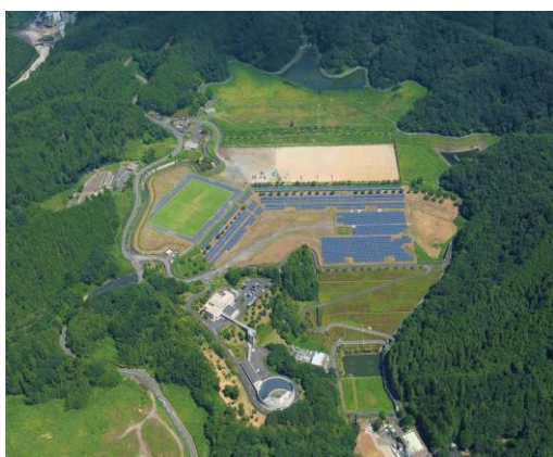
谷戸沢処分場の外観航空写真 (45.3ha)
