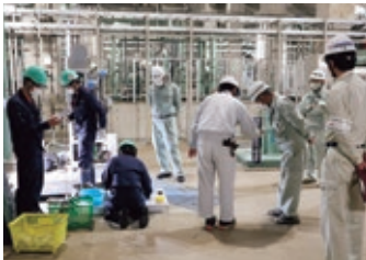
環境調査立会の様子
