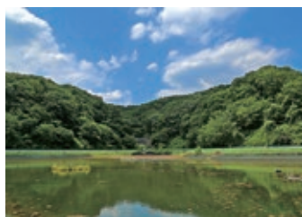
清流復活用貯水池
