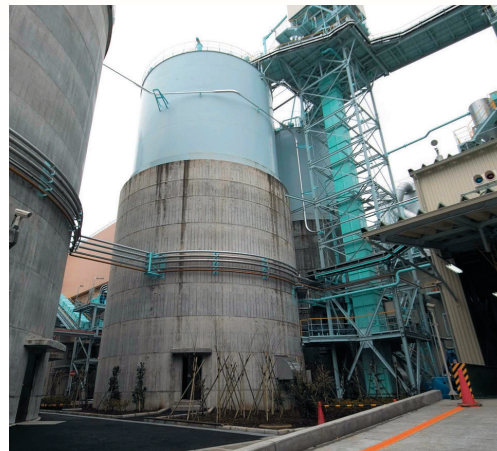
④ エコセメント貯留タンク
