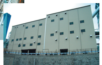
⑥ 重金属回収設備棟
