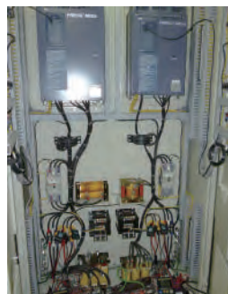
クリンカクーラを省エネ運転させる制御盤
