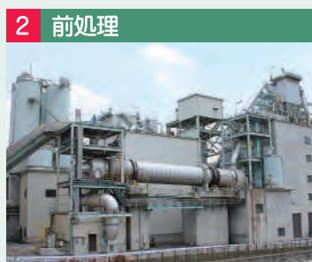
2 前処理 焼却灰を乾燥、粉砕して石灰等の副資材を混ぜます。
