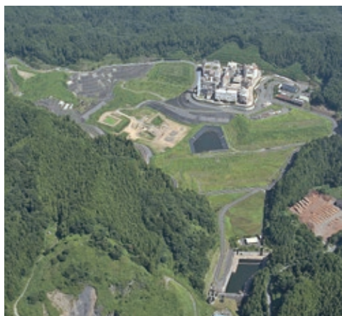
日の出町ニツ塚廃棄物広域処分場
