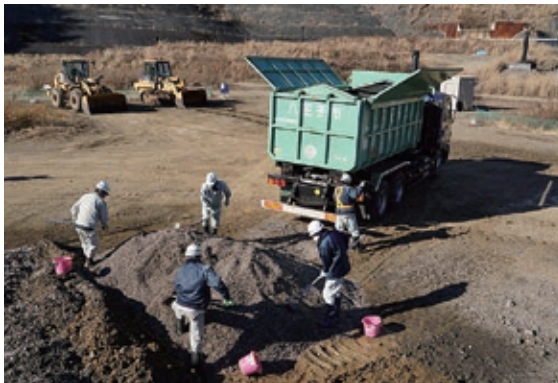
平成 29 年度以前の不燃ごみ埋立ての様子
