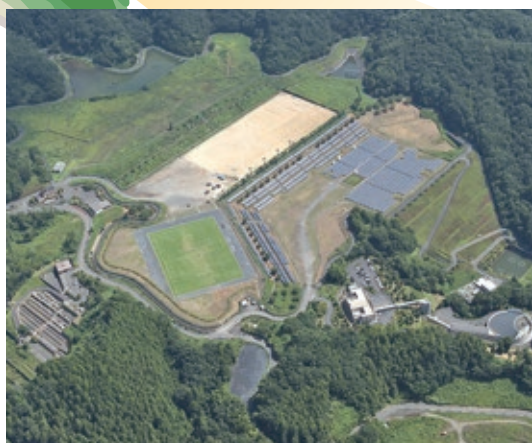
日の出町谷戸沢廃棄物広域処分場
