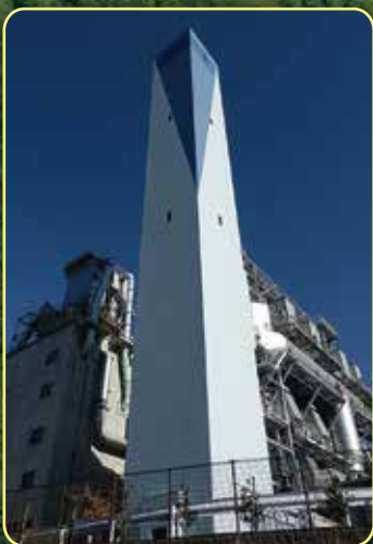
とうきょう 東京たまエコセメント化施設
