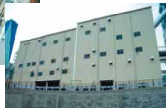
⑥ 重金属回収設備棟
