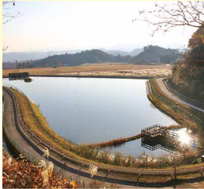
清流復活用貯水池
