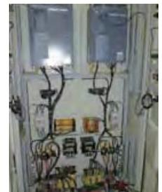
クリンカクーラを省エネ運転させる制御盤
