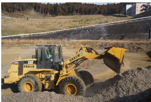
図 7-3 不燃物の搬入（左上）、搬入物チェック（右上）、埋立作業（即日覆土）（下）
