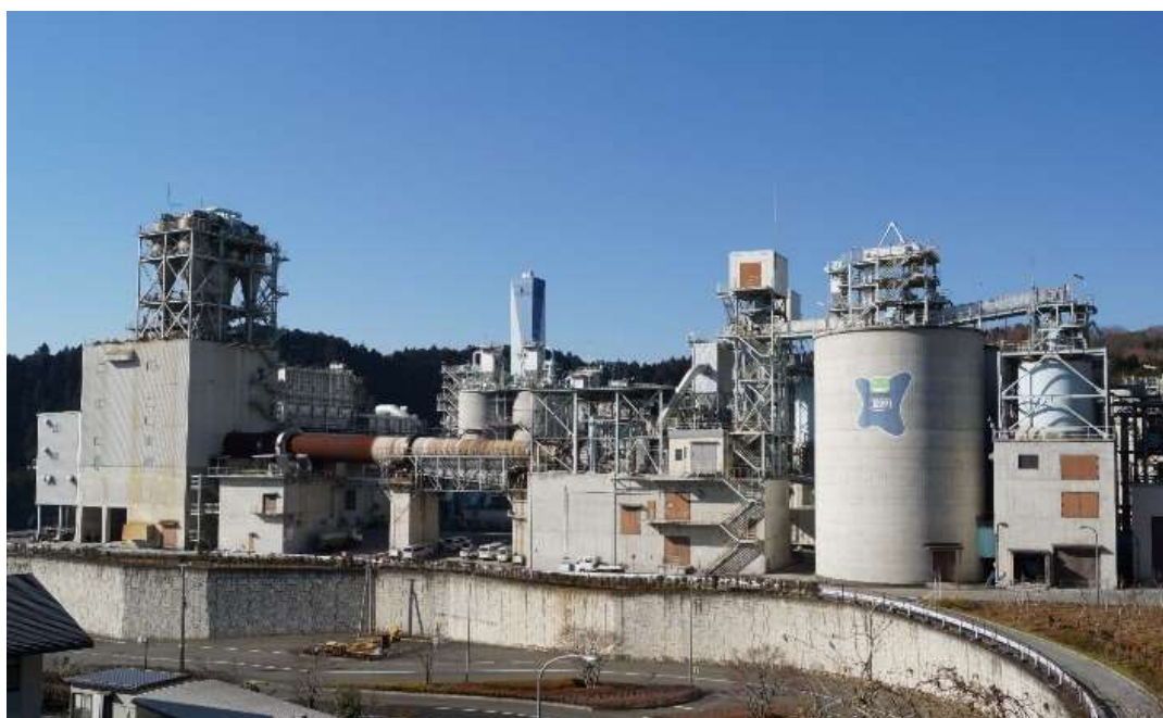
図 1-2 エコセメント化施設
