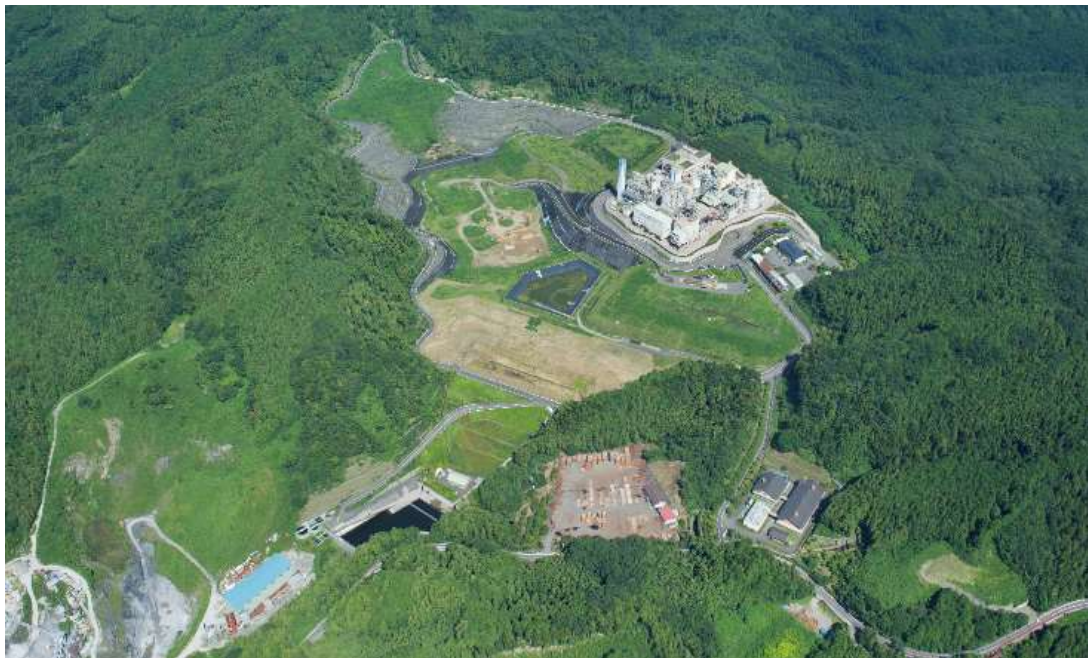
図 1-1 二ツ塚廃棄物広域処分場
