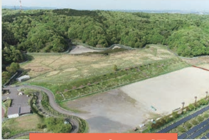
谷戸沢処分場
