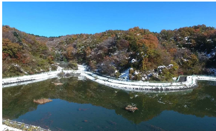
清流復活用貯水池
