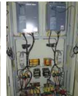
クリンカクーラを省エネ運転させる制御盤
