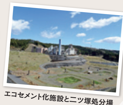
エコセメント化施設とニツ塚処分場
