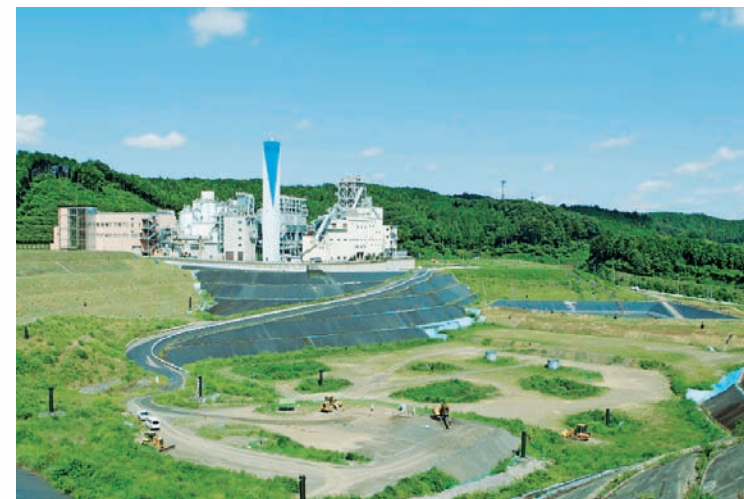
不燃ごみが埋め立てられている二ツ塚処分場、奥に見えるのがエコセメント化施設
