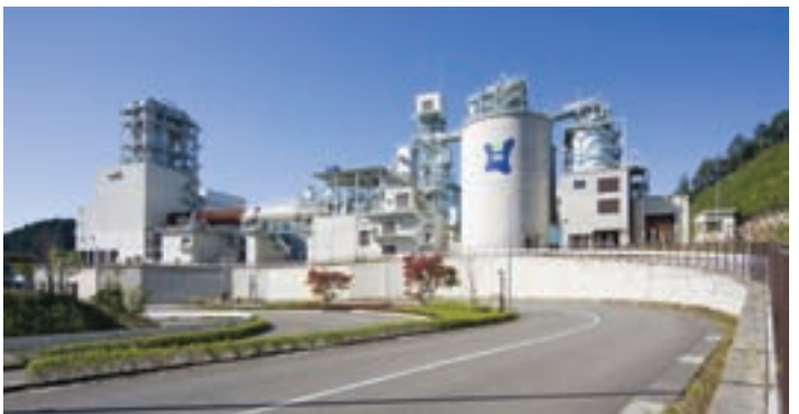
平成18年7月から本格稼働している東京たまエコセメント化施設
