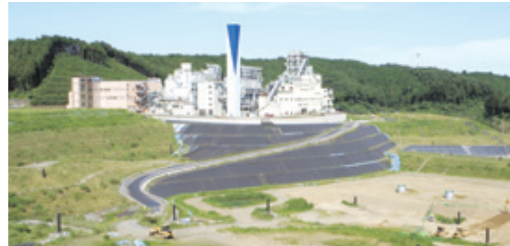
▲二ツ塚処分場とエコセメント化施設
