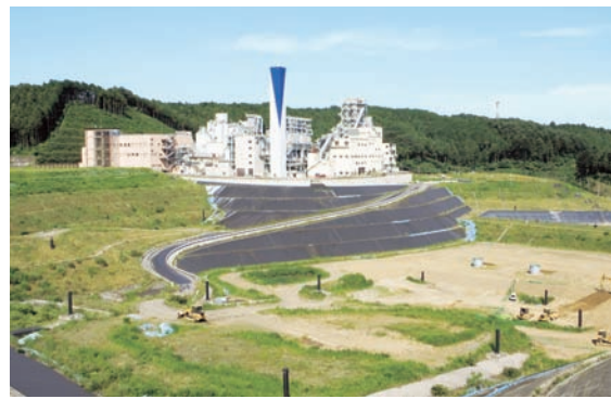
◀不燃ごみが埋め立てられる二ツ塚処分場。奥に見えるのがエコセメント化施設
