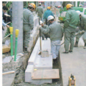
道路橋梁として、普通セメントと同じように使われているエコセメント。
