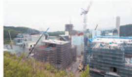
建設中のエコセメント化施設(平成17年5月撮影)。
