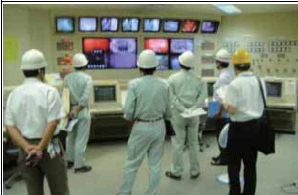
施設の主要設備の状況がTV画面に映し出されている
