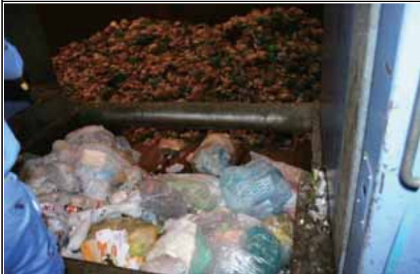
可燃ごみピット投入口の状況
