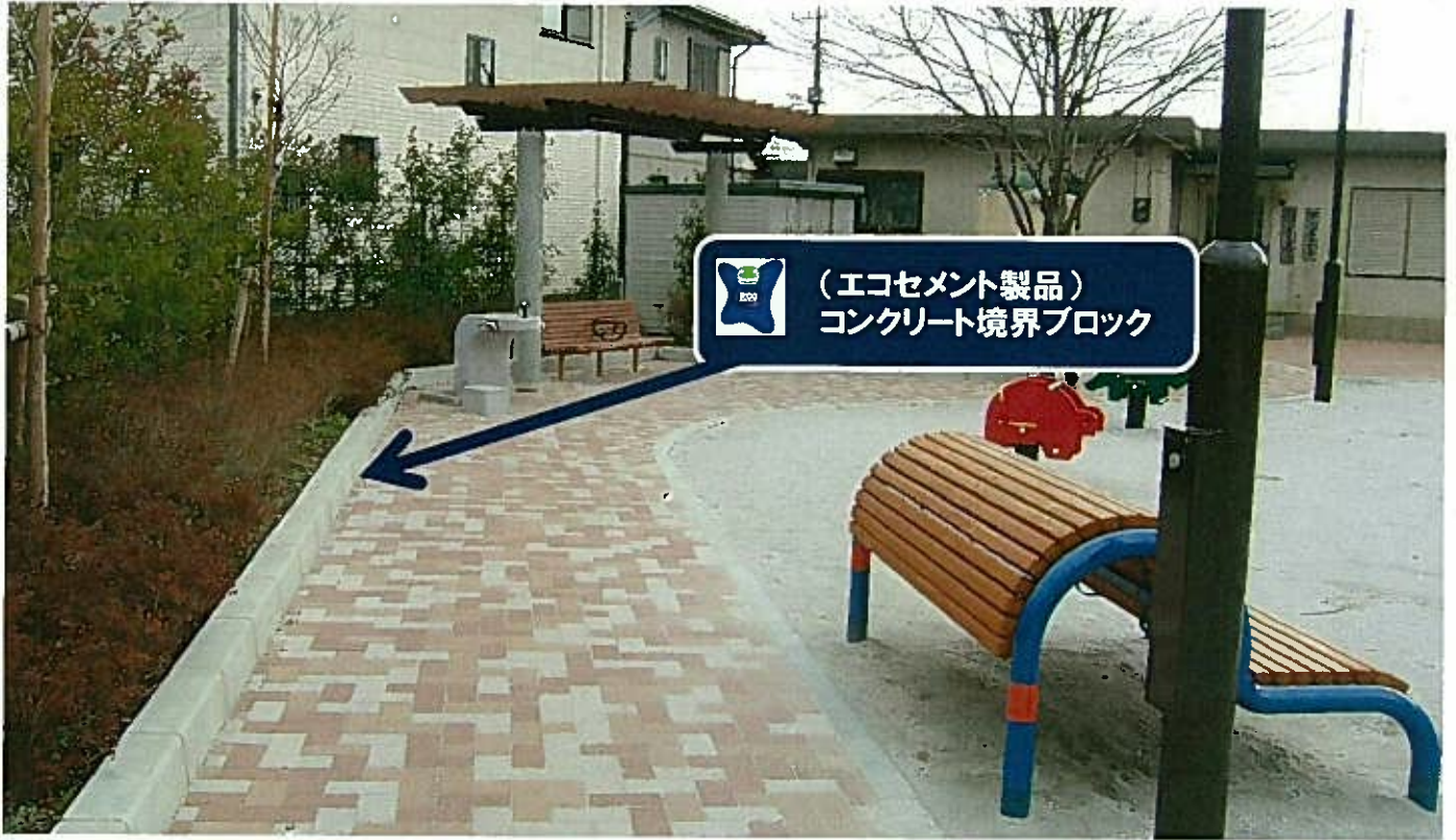
（東京たまエコセメント製品の使用写真）
