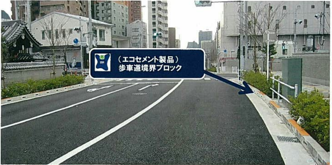
(東京たまエコセメント製品の使用写真)
