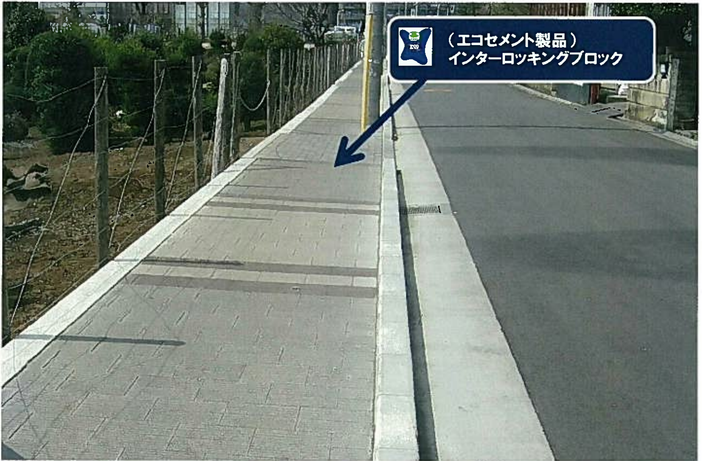
（東京たまエコセメント製品の使用写真）
