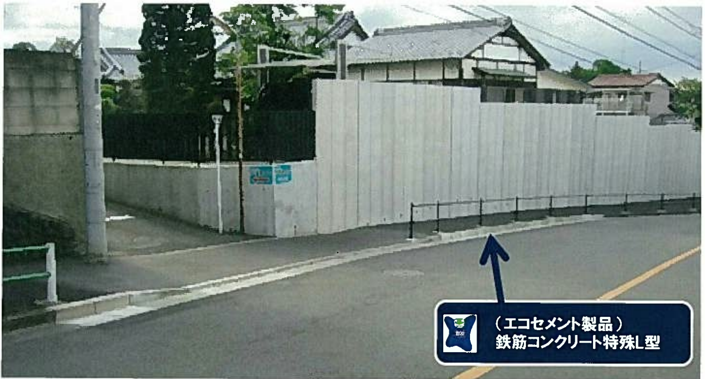
(東京たまエコセメント製品の使用写真)
