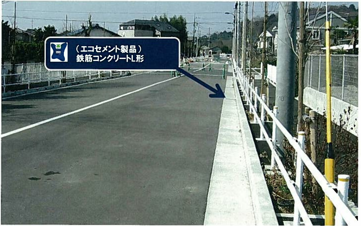
(東京たまエコセメント製品の使用写真)
