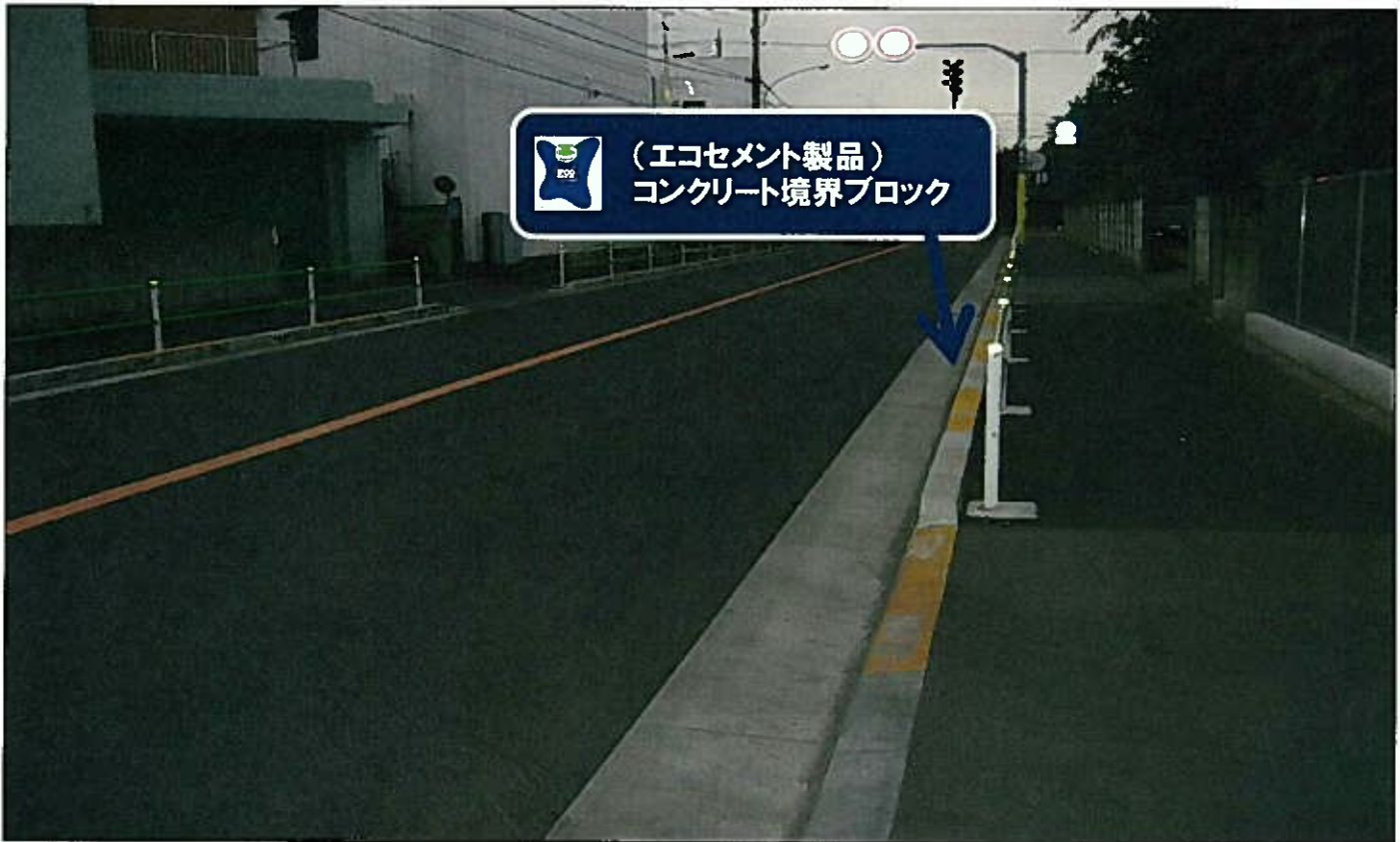
(東京たまエコセメント製品の使用写真)
