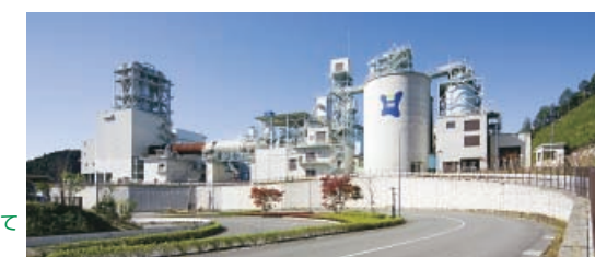
昨年7月より本格稼働しているエコセメント化施設
