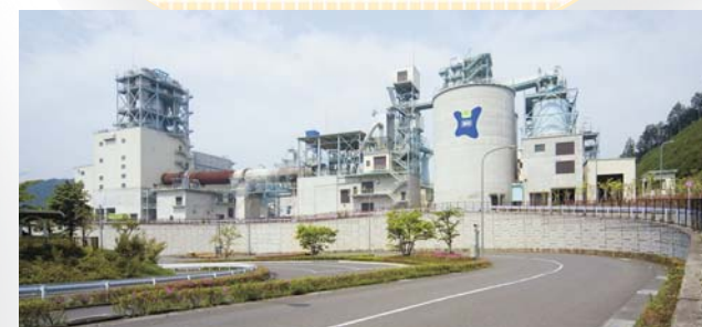
可燃ごみ焼却灰をリサイクルするエコセメント化施設(平成19年5月撮影)。
