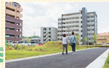
道路の両端にL形側溝のエコセメント製品が活用された稲城市の歩行者専用道路。稲城市では、このほか2カ所でエコセメント製品を使用した舗装道路を整備中。
