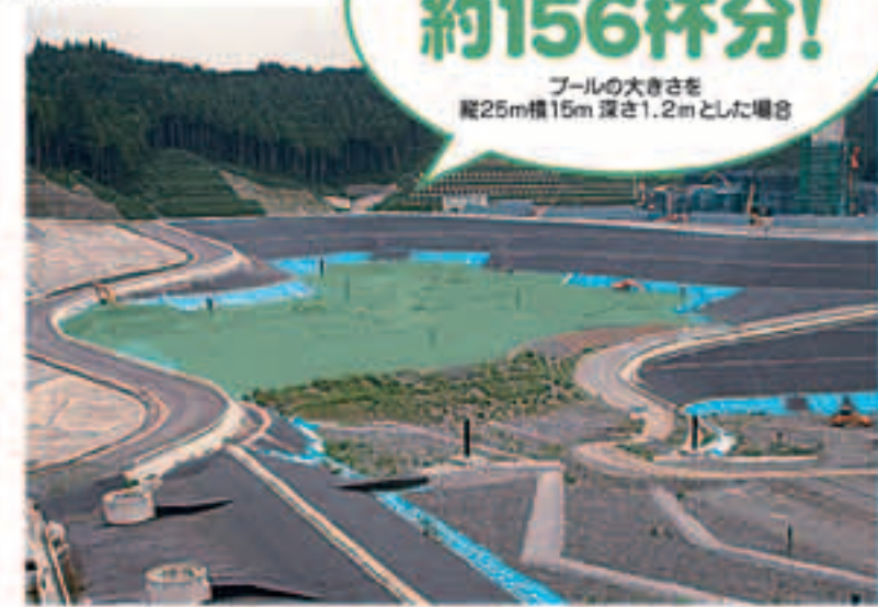
10カ月後では、壁面の1段分がすでに埋め立てられています。平成16年8月11日撮影。
