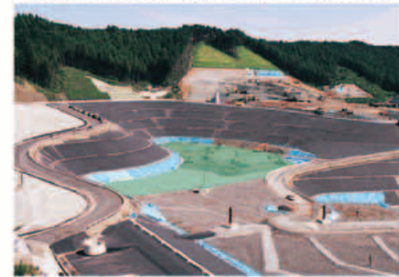
二ツ塚処分場埋立エリア、平成15年10月3日撮影。
