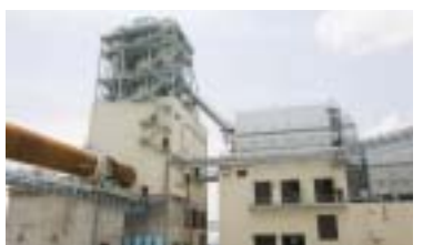
円筒形のロータリーキルン(左)と排ガス処理棟(中央)、重金属回収設備(右)
